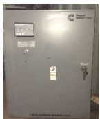
Quadro de Transferência Automático e Quadro de Transferência Manual
