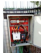
Quadro de Transferência Automático e Quadro de Transferência Manual
